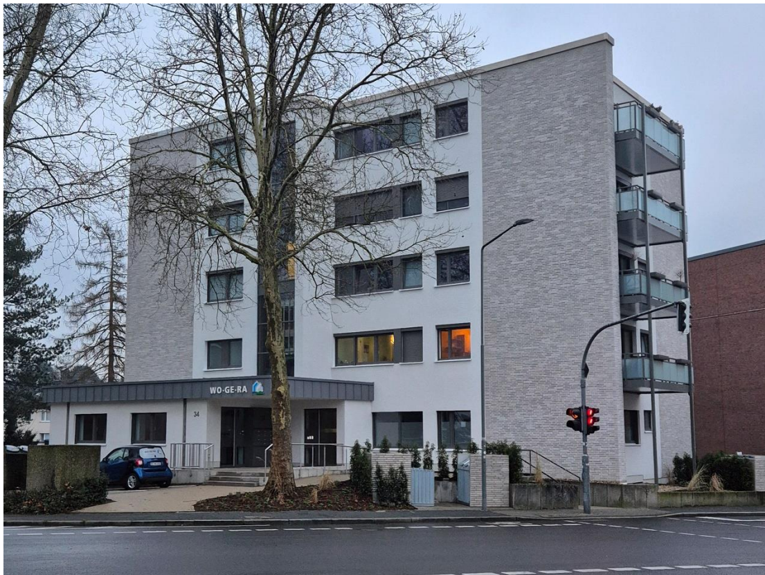
Ansicht Verwaltungs- und Wohngebäude Poststraße 34
