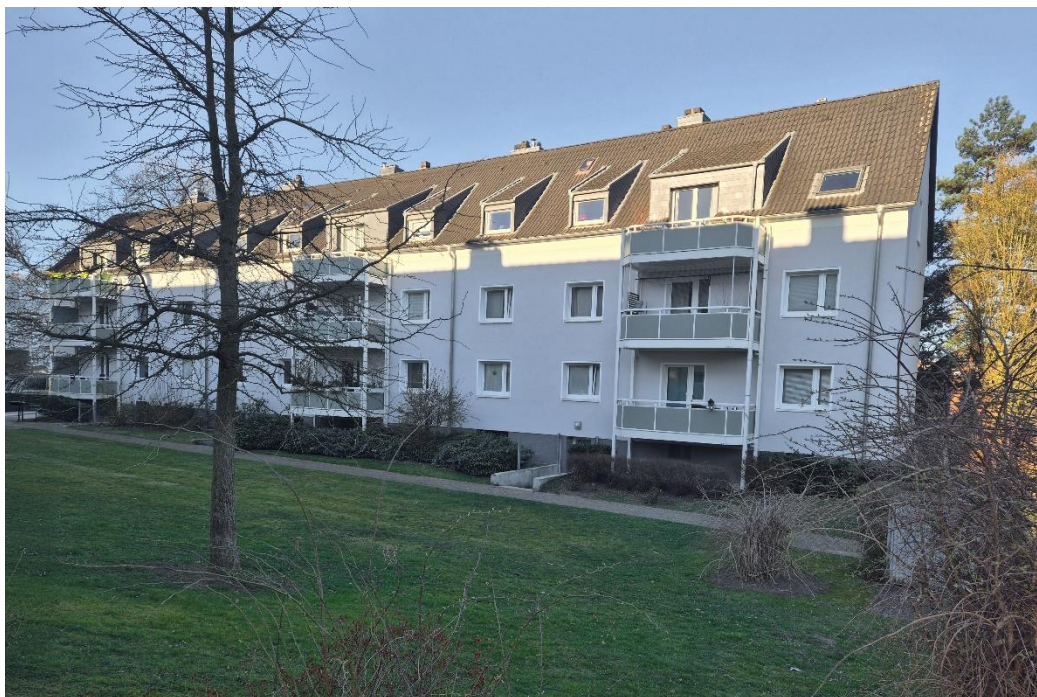
Fassadenrenovierung Homberger Straße 53 – 53b
