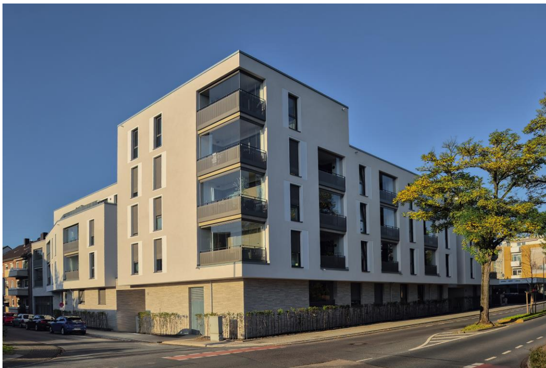
Straßenansicht Gartenstraße 15-17, Hans-Böckler-Straße 20
