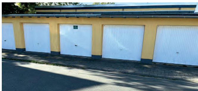
Instandhaltung Garagen Fröbelweg
