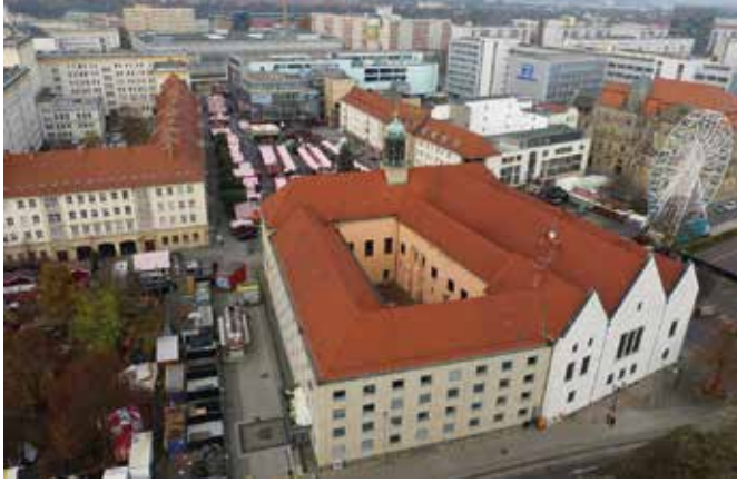
Das Alte Rathaus (Rückseite), das sich am Alten Markt befindet.
