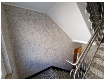
Erneuerung von Treppenhausgeländern
