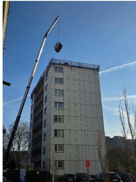
Dacherneuerung Ratingen - West
